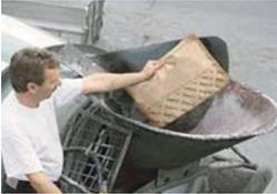
empirique suivante peut être adoptée: 1 mn de gâchage pour chaque mètre cube de béton, à la vitesse de rotation maximale du tambour de la bétonnière. Longueur : 19 mm. Produit spécifique pour le renforcement tridimensionnel des bétons en général (coulées massives, revêtements de sol industriels, etc...) - Durée de conservation: illimitée - Consommations: 1 sachet de 750 gr/m<sup>3</sup> de béton - Aspect: fibres - Couleur: blanc - Conditionnement: boîte de 18 sachets (13,5 kg) de 750 gr. chacun.
