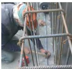
**3. Ermetizzazione delle connessioni e dei giunti mediante predisposizione, in opera, di waterstop idroespansivi: Predisposizione dei presidi di ermetizzazione in corrispondenza delle riprese di getto, sia orizzontali che verticali, mediante l'installazione di opportuno waterstop in bentonite sodica e polimeri aggreganti, WATERSTOP B/25.20 del metodo BETONSAFE, della sezione di mm. 25 x 20, con capacità espansiva di circa 4-5 volte il suo volume iniziale.**
