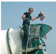
**2. Al fine di conseguire la necessaria attitudine antifessurativa, il rinforzo, tridimensionalmente diffuso, dovrà essere ottenuto mediante addizione del peculiare mix di fibre polipropileniche multifilamento e fibrillate a rete, FIBRE ECOMICS 180 del metodo BETONSAFE della lunghezza di mm. 18, in ragione di 1 kg/mc (n° 1 sacchetto/mc).**
