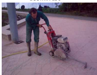
5 - Realizzazione dei giunti nei punti nascosti della sagome
