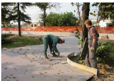
3 - Pressatura della pellicola di quarzo con appositi stampi sagomati
