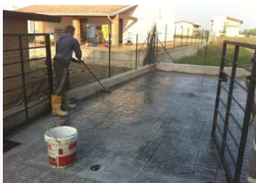
7 - Applicazione a rullo della speciale resina protettiva
