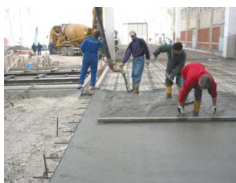
1 - Stesa del calcestruzzo additivato con MICROPLUS e FIBRE ECOMIX 190
