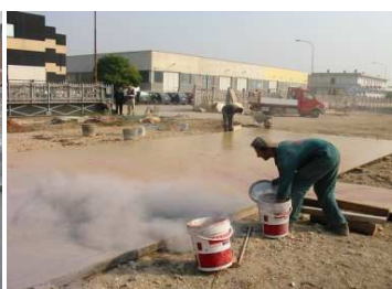
2 - Spolveratura indurente della superficie fresca con speciali quarzi colorati
