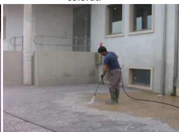
6 - Asportazione della polvere di quarzo residua e del lattime dei giunti con idrolavaggio
