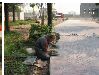
4 - Particolare della pressatura dei bordi del pavimento
